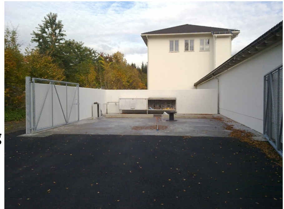
Mottaksstasjon på Ris
